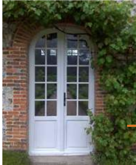
Modèle deux vantaux avec panneau plate-bande en partie basse et petits bois collés
