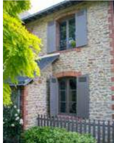
Finition des volets réalisée par le client
