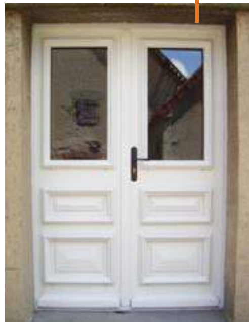
Porte deux vantaux avec panneau tas de sable et moulure grand cadre
