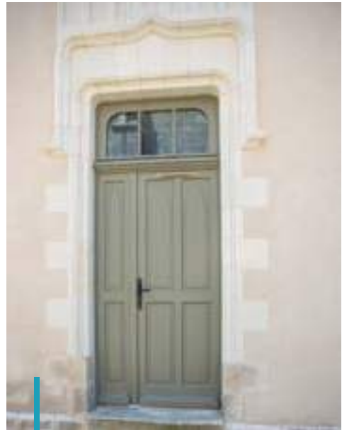
COLORADO tiercé sans moulure grand cadre avec défonçage ogive sur panneau plate bande. Imposte fixe
