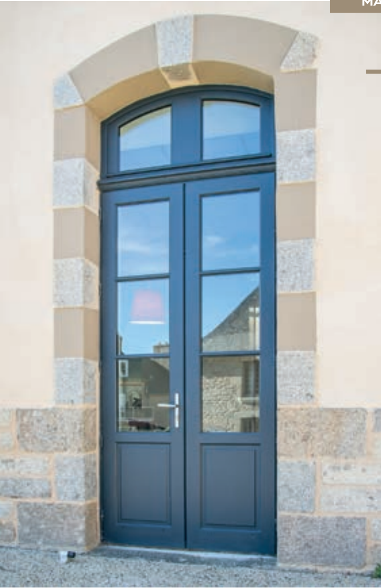
Renovation de l'ancien avec petits bois collés et imposte fixe en faux ouvrants
